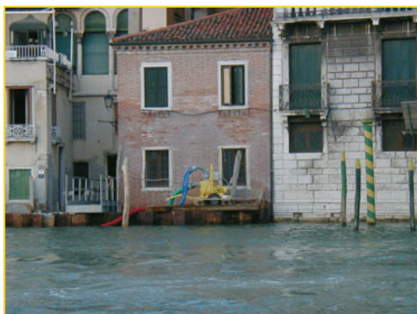
Lavori di conservazione a Venezia Restoration work at Venice Trabajos de conservación en Venecia
